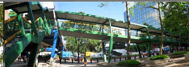
現有行人天橋 EXISTING FOOTBRIDGE
